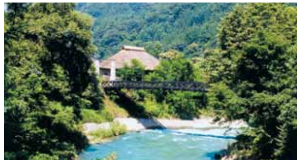
大出吊橋 (E-4)
